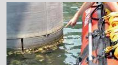
カキ殻のついた岸壁への接近もウレタン注入だから安心
